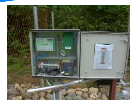
Einbau im Schaltschrank
