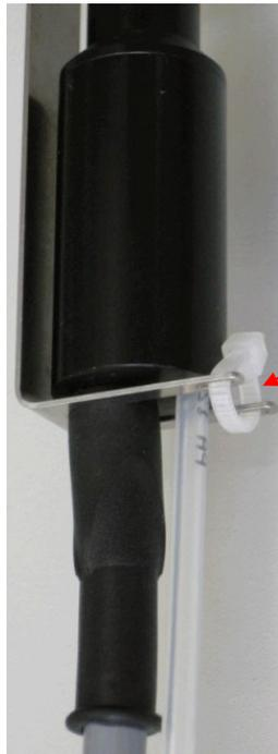
Schliessen Sie die offenen Enden des Metallwinkels mit Kabelbindern, wie im Bild dargestellt.
